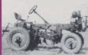
... Prototype met een aan de voorkant opgebouwde DKW tweetakmotor
