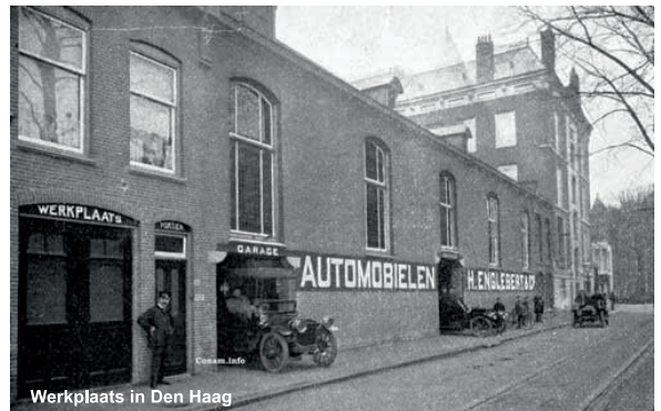
Werkplaats in Den Haag
