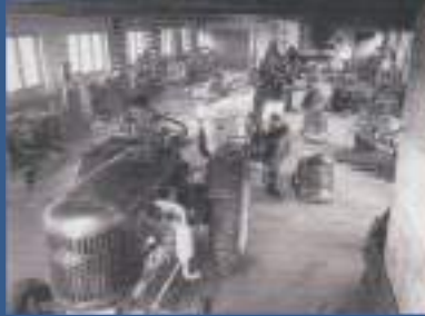
Zeldzame opnames van de Rola-productie die tussen 1953 en 1955 liep in Edenhall in Vallåkra. Destijds werden er luchtgekoelde Deutz-motoren met twee en drie cilinders geïnstalleerd. Alleen de vooras en een paar kleine onderdelen werden bij Edenhall gemaakt, de rest kwam per trein en vrachtwagen uit Duitsland. Sommige bronnen spreken van 18 Rola-tractoren, maar het is niet bekend hoeveel er daadwerkelijk zijn geassembleerd.
