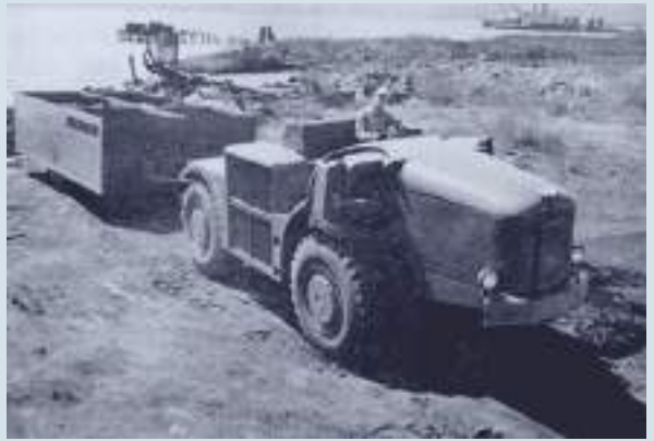
Een prototype van een door stoomkracht aangedreven trekker in de Yuba fabriek in Benicia waarvan er tussen 1946-1951 verschillende zijn gebouwd. Deze trekker had een totaal vermogen van 200 pk!
