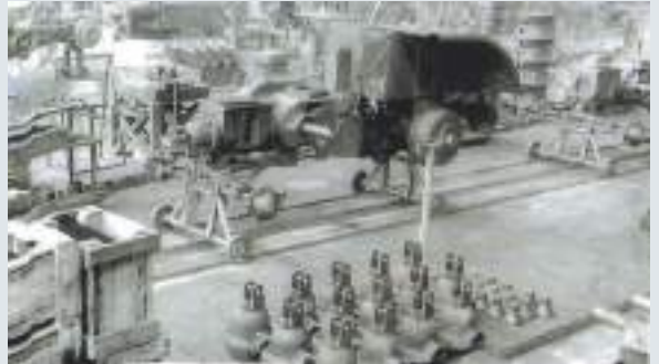
De montagelijnen begin jaren 50 van de 302 een 1-cilinder tractor met een vermogen van 30 pk. De tractor heeft 6 versnellingen, 5 vooruit en 1 achteruit.
