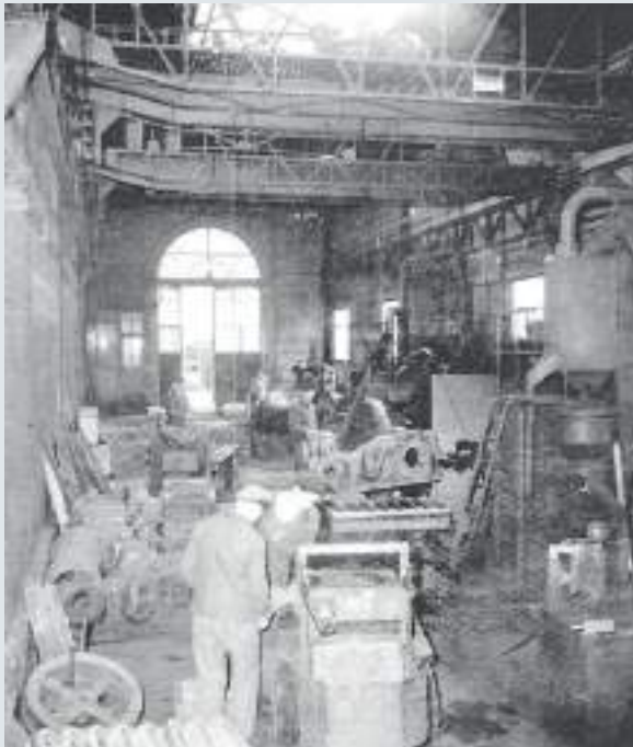
Een kijkje in een werkplaats bij SFV midden jaren 40 waar de HV2 werd gebouwd onder primitieve omstandigheden. Vergelijk deze foto met de volgende foto uit begin jaren vijftig met een zicht op de montagelijnen van de 302.
