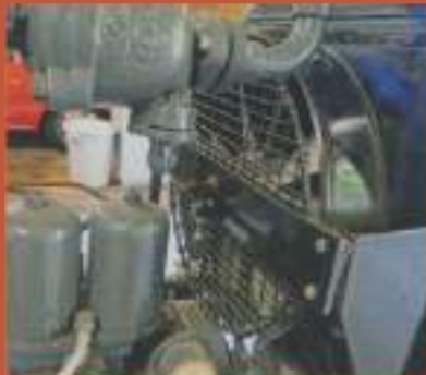
De afvalwarmte van de motor is gering. De ventilator blaast de lucht door het radiatorblok, waardoor de temperatuur in de garage in de winter op peil blijft.
