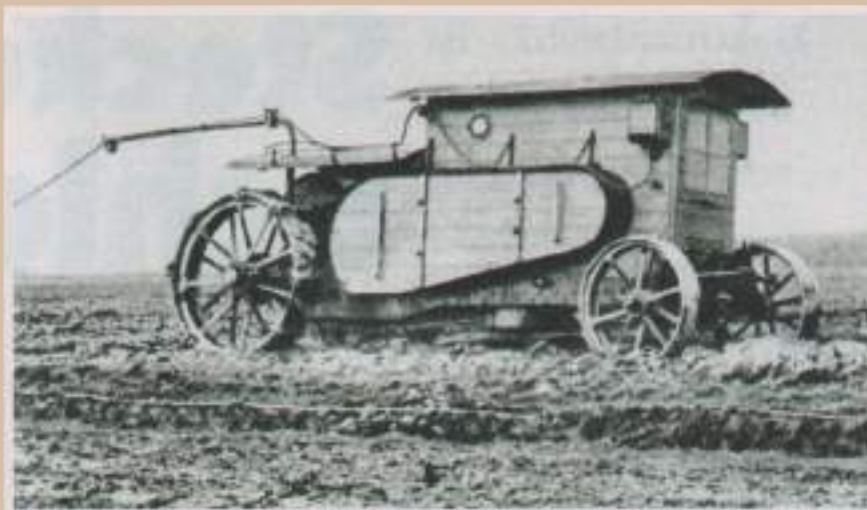
◀ Heen en weer: De kantelploeg, die vervolgens door de elektro trekker en de "tegenwagen" aan een kabel heen en weer over het veld werd getrokken.
