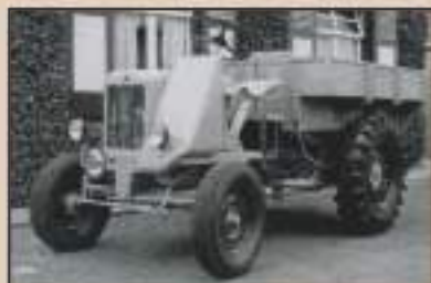
Een andere versie: Naast het model met cabine boven de motor was de MCE ook leverbaar in een openluchtversie, genaamd "Type A", waarbij de motor aan de rechterkant was gemonteerd.
